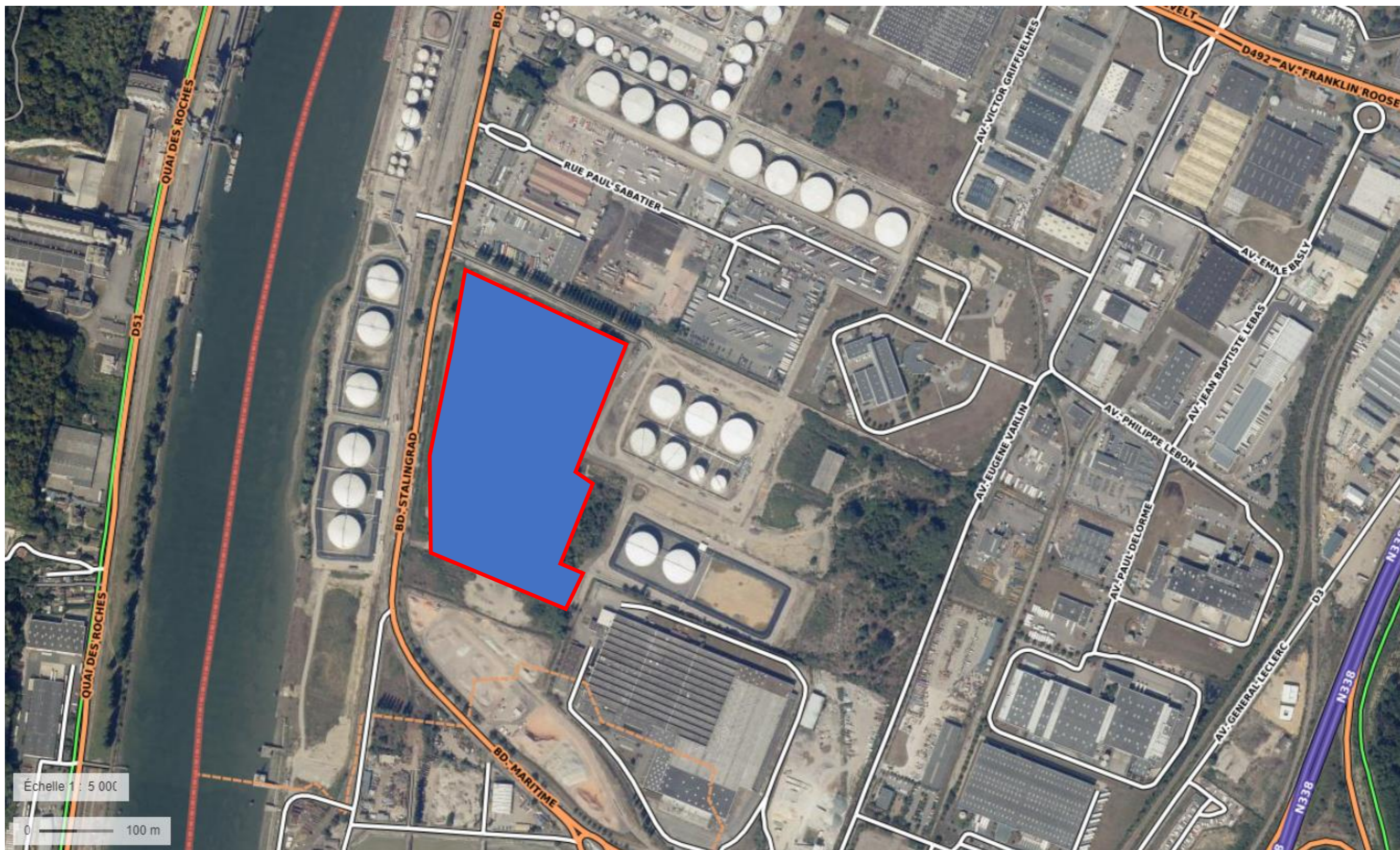
Échelle 1 : 5 000 0 100 m ■ Périmètre du projet, environ 85514m 2 . Boulevard Stalingrad, 76120 Le Grand Quevilly
